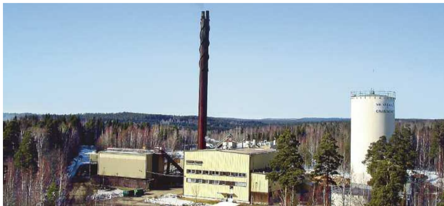
Craboverket, som förser många hushåll i Fagersta med fjärrvärme, tar vara på spillvärme från industrin.
