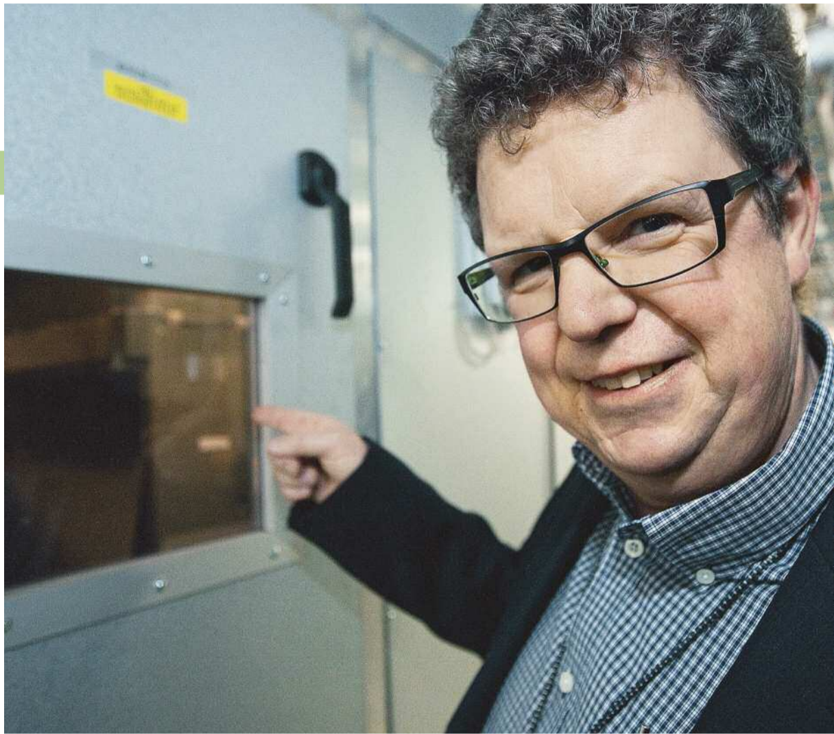
Värme blir kyla. Vid Seco Tools i Fagersta används överskottsvärme från produktionen till att kyla lokalerna. Miljösamordnaren Gunnar Lobell visar kylanläggningens aggregat, som finns i en överbyggnad på den nya verkstadslokalens tak.
