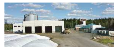
Växtkrafts biogasanläggning på Gryta i Västerås. Här rötas matrester och vallgrödor.
